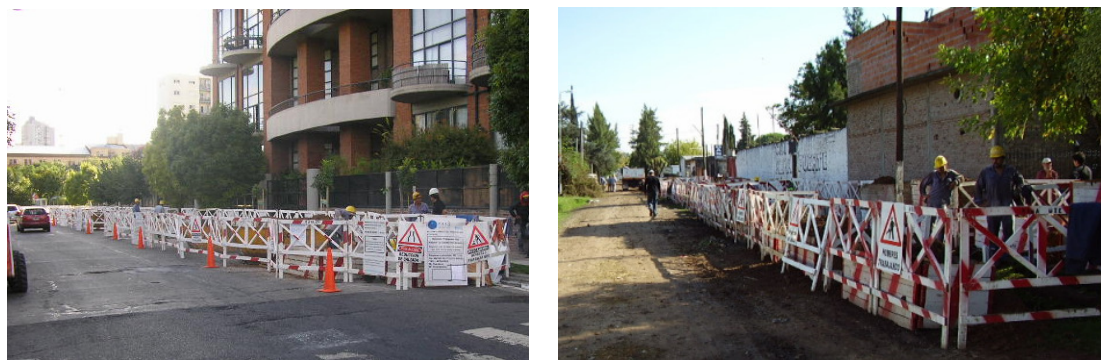
Fig. 3. Ejecución de obra civil
