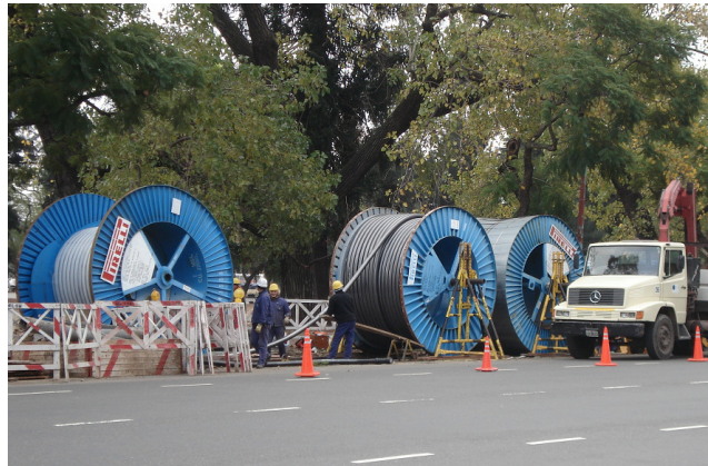
Fig. 4. Tendido de Conductores
