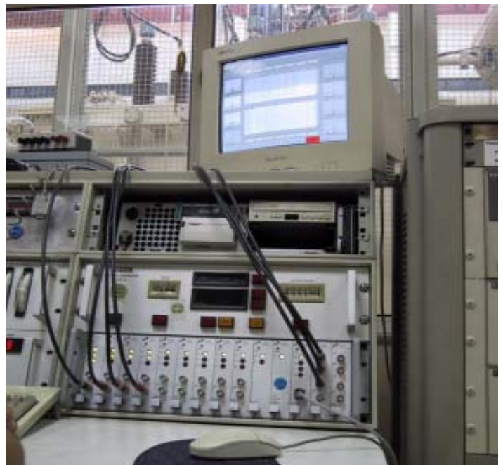
Fig. 1 – Instrumento de adquisición de descargas parciales de ocho canales en paralelo
