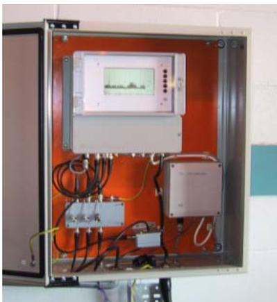
Fig. 8 Unidad de adquisición ICM monitor, instalada en un Gabinete, con un módem opcional, caja de terminación/conexión de couplers, y un HF-CT.
