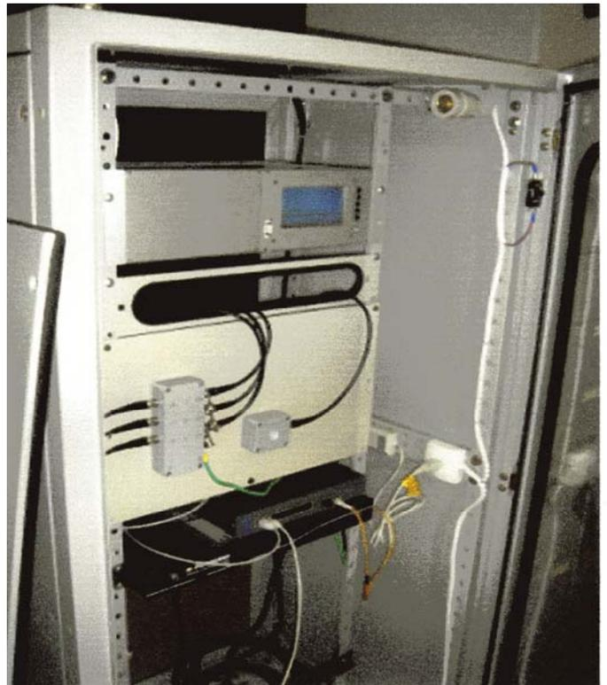
Fig. 8, Unidad de monitoreo (ICM Monitor) durante la instalación.
