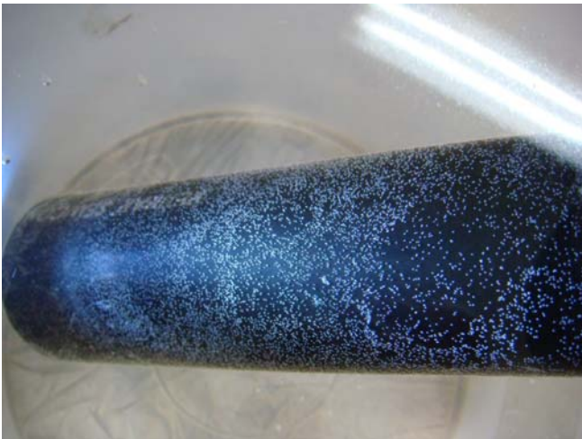
FORMACION DE MICROBURBUJAS EN SUPERFICIE EXTERNA (SEMICONDUCTORA) DE UN CABLE DE MT, PRODUCTO DE LA DESGASIFICACION
